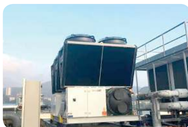
Oil free chillers 無油式製冷機
